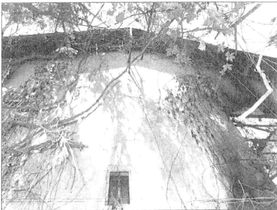
Vue de la façade côté jardin.
