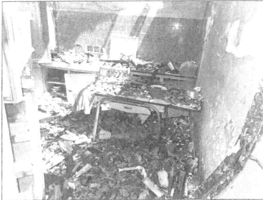
Vue de la cuisine de la maison après l'incendie.
