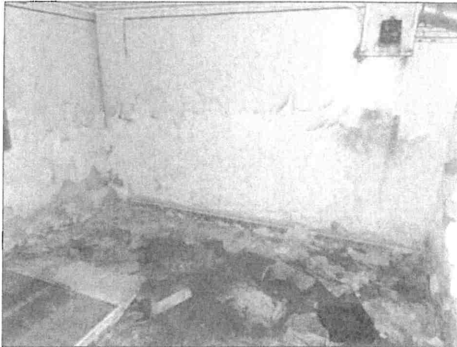
Vue d'une pièce annexe au rez-de-chaussée.
