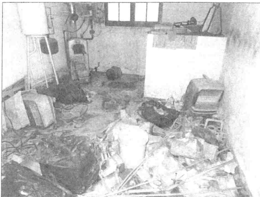
Vue d'une pièce annexe au rez de chaussée.
